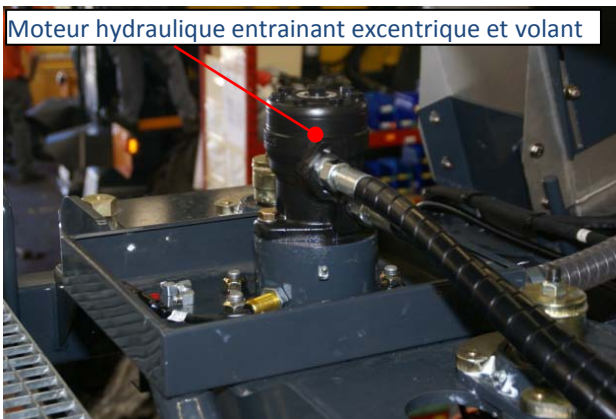
Fig 3.3 : Solution à moteur hydraulique, châssis fixe : vue du moteur
